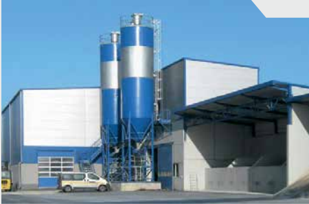
Instalacja mieszania betonu
