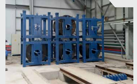
Składowanie i rozwijanie drutu sprężającego
